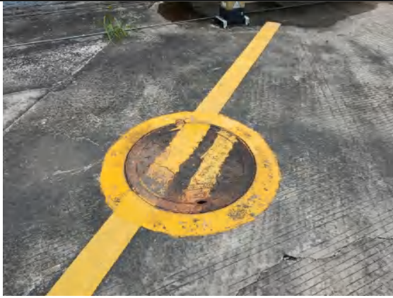
站内污水井盖
