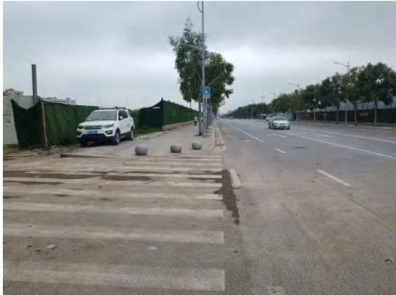
电缆沟路面硬化
