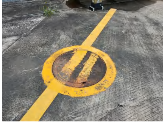
站内污水井盖
