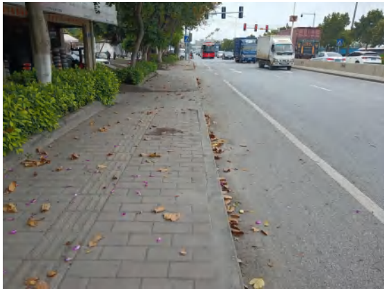
本项目电缆线路沿线
