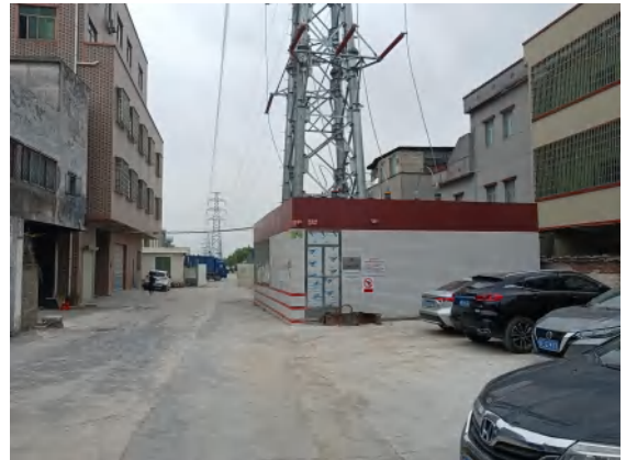
新建电缆上线塔基 T 接点
