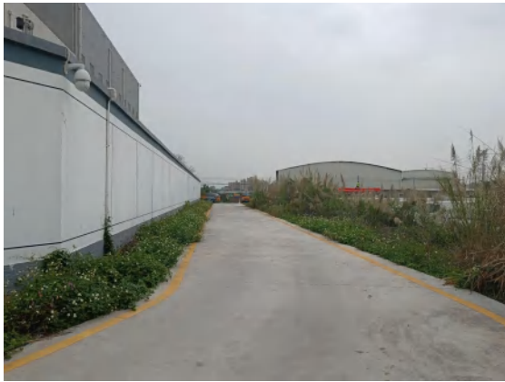
变电站南侧电缆出线侧
