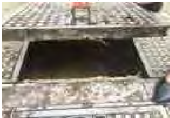
临时食堂隔油池
