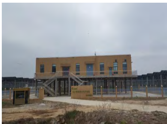
光伏场区开关站
