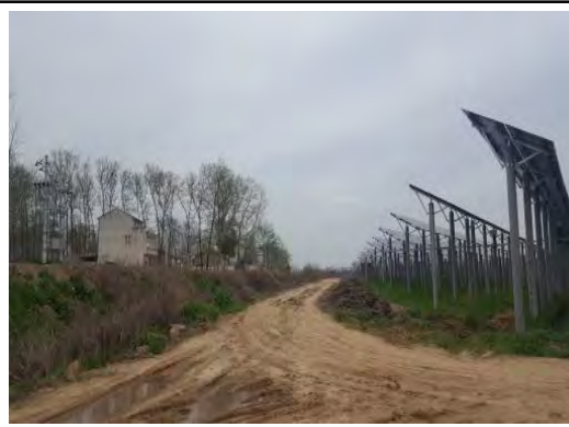
光伏场区北侧外环境
