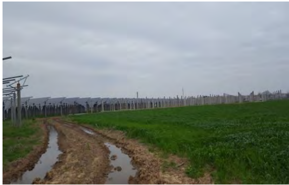
施工期光伏场区临时道路
