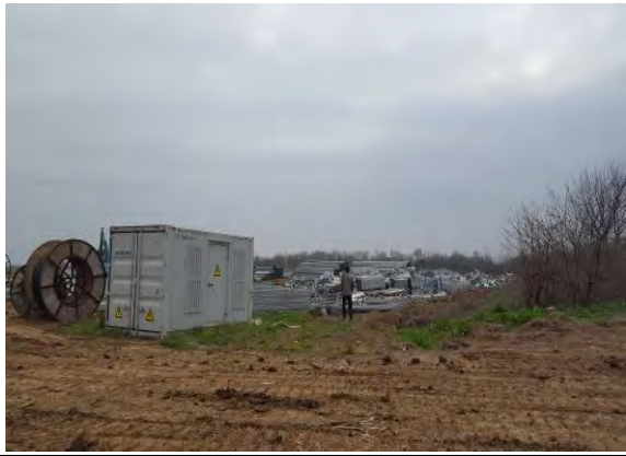
施工期临时生产区
