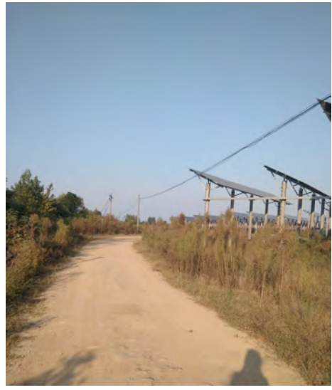
光伏场区东侧外环境
