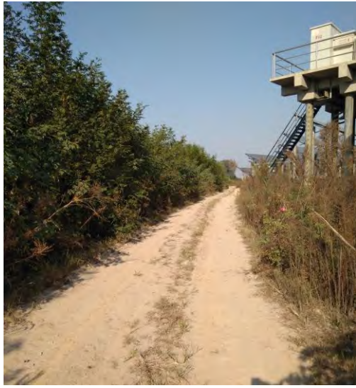
光伏场区西侧外环境
