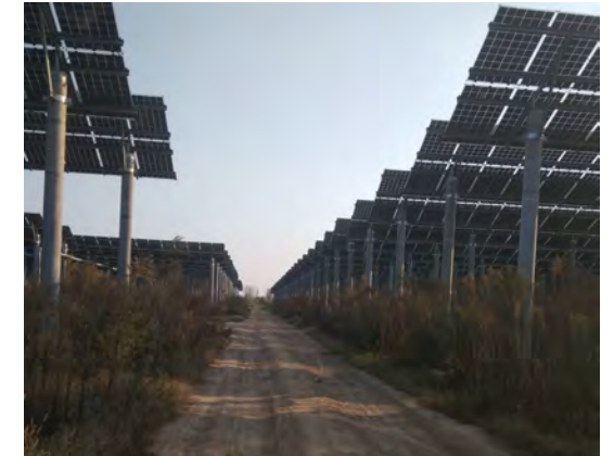
光伏场区道路
