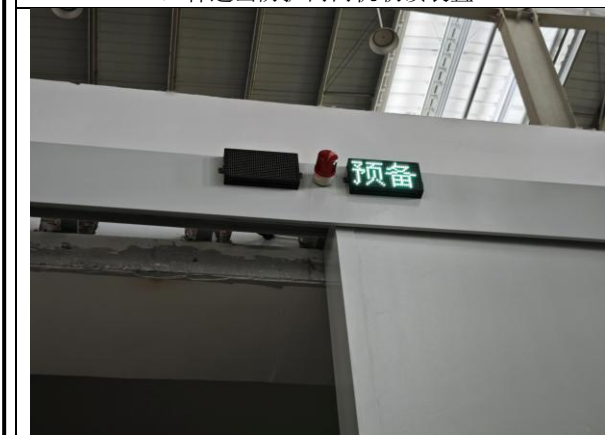
工作状态指示灯（预备状态）及声光报警灯
