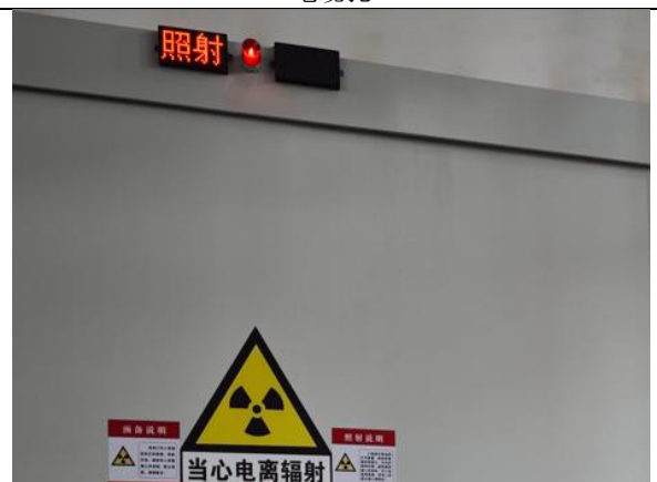
工作状态指示灯（照射状态）及声光报警灯
