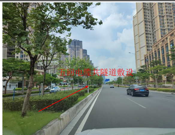
电缆线路沿天贵北路敷设
