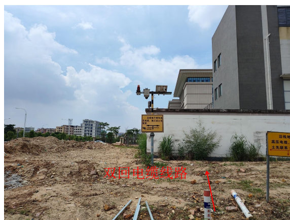
电缆线路接入 110kV 平石（三东）变电站
