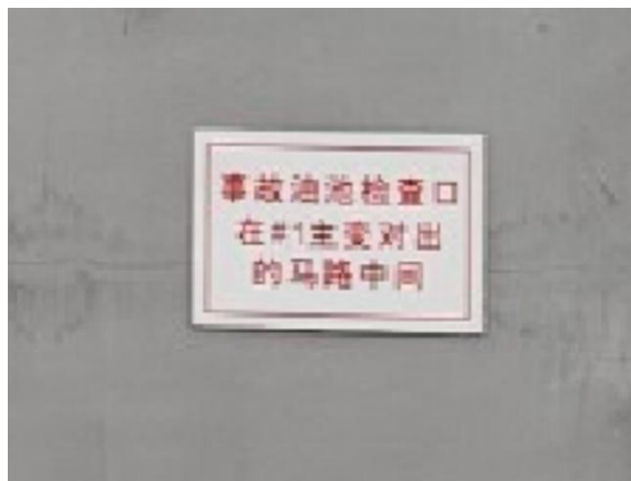
事故油池检查口
