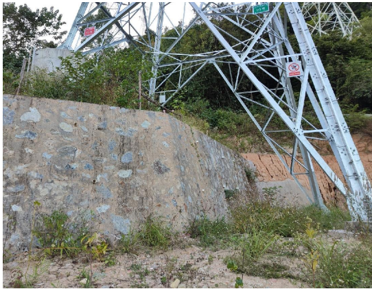
塔基下方植被恢复、采用高低腿塔基、挡土墙
