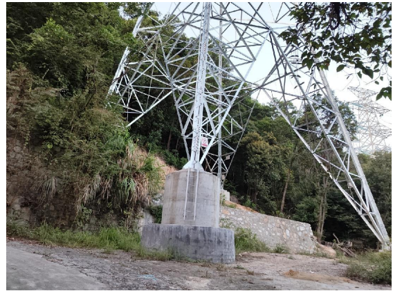
采用高低腿塔基、挡土墙、塔基固化
