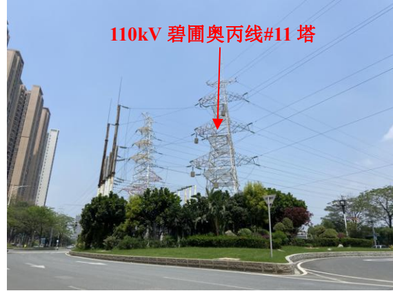
T 接点 110kV 碧圃奥丙线#11 塔
