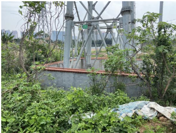
220kV 黄橄乙线#33 塔基恢复
