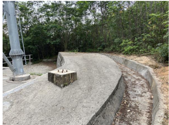
塔基护坡及排水沟 (龙头山森林公园内塔基)
