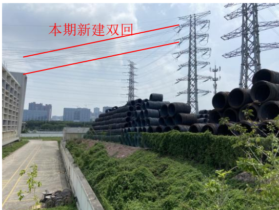
220kV 橄榄变电站构架~220kV 黄橄#33 段
