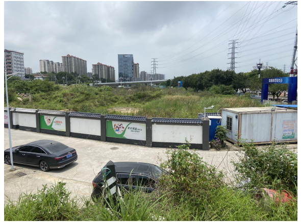
线路牵张场平整绿化恢复
