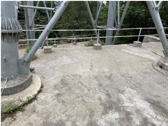
塔基采用方位不等高腿铁塔 (龙头山森林公园内塔基)
