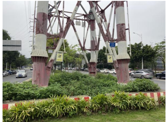
220kV 黄橄乙线#26 塔基恢复
