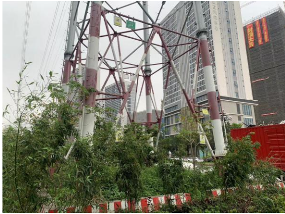
220kV 黄橄乙线#24 塔基恢复
