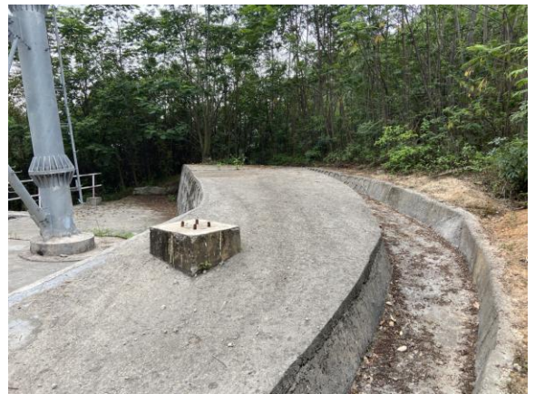
塔基护坡及排水沟
