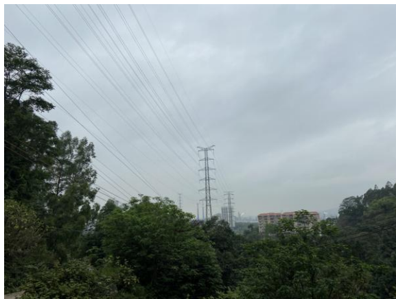
橄榄~黄埔电厂 220kV 线路采用高跨设计 经过龙头山森林公园
