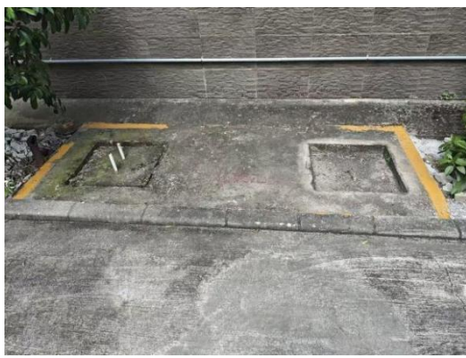
站内原有化粪池
