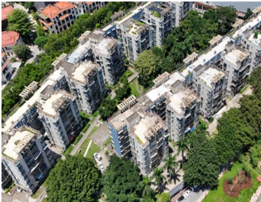
110kV 汇景变电站东侧外环境
