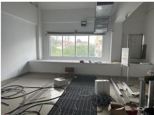
站内预留#3 电容器组位置
