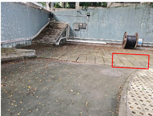
站内原有事故油池位置
