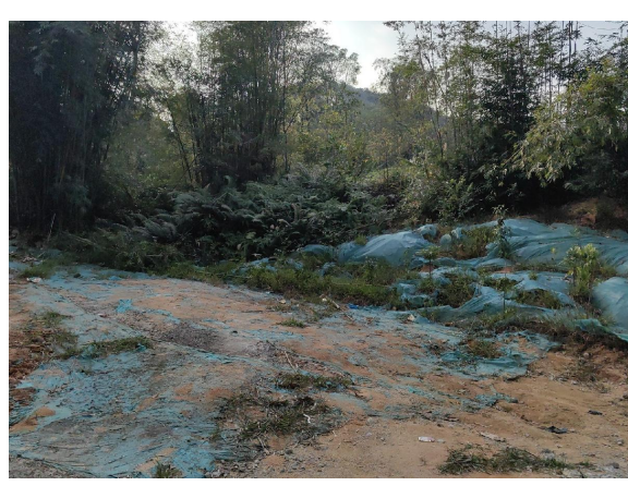
施工便道植被恢复
