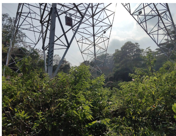
塔基下方植被恢复
