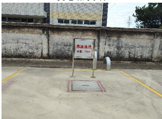
变电站本期新建事故油池
