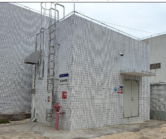
本期新建消防水泵房
