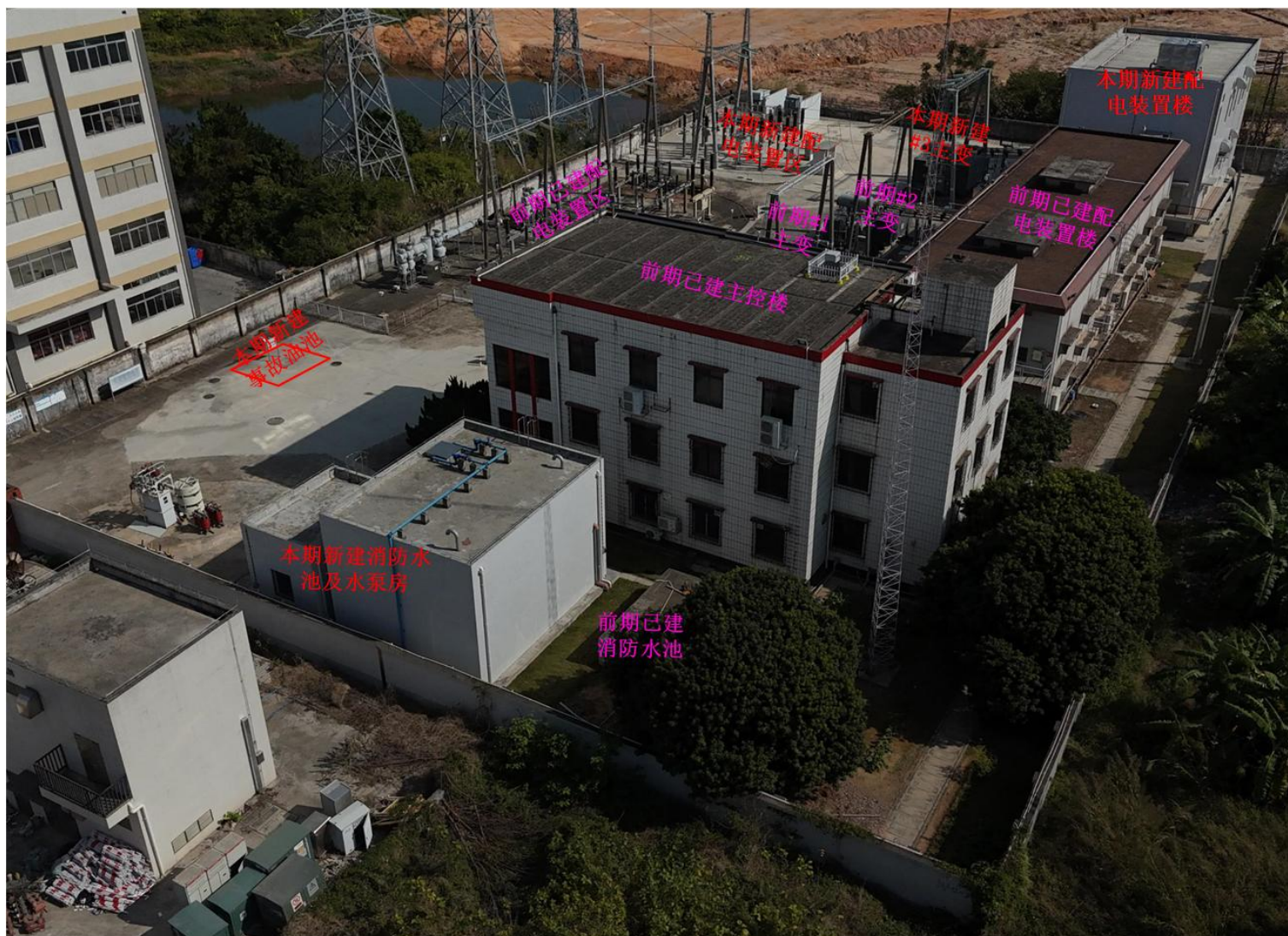
图4-5 110kV沙滢变电站平面布置实景图
