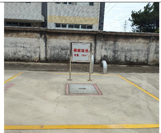
本期新建事故油池
