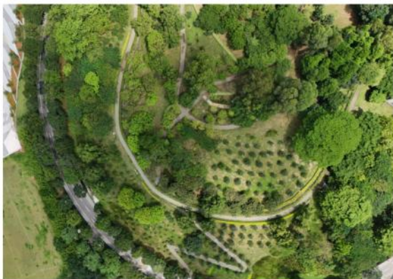
电缆敷设场地复绿
