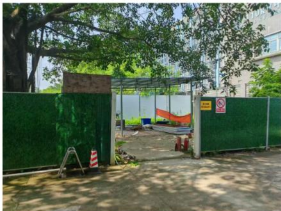
建筑废弃物专业堆放点
