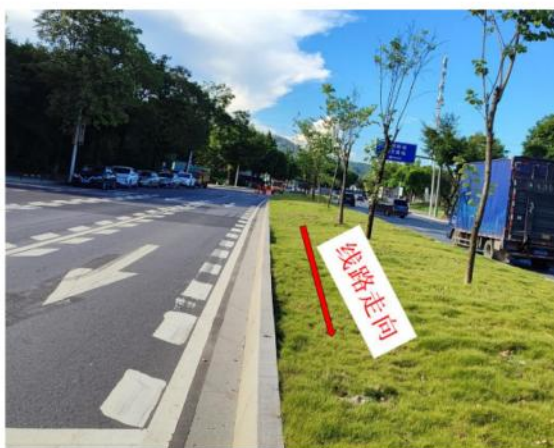
本工程电缆线路沿线（高唐路）
