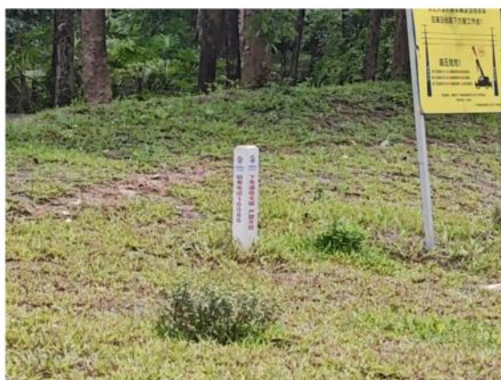
地下电缆警示标识
