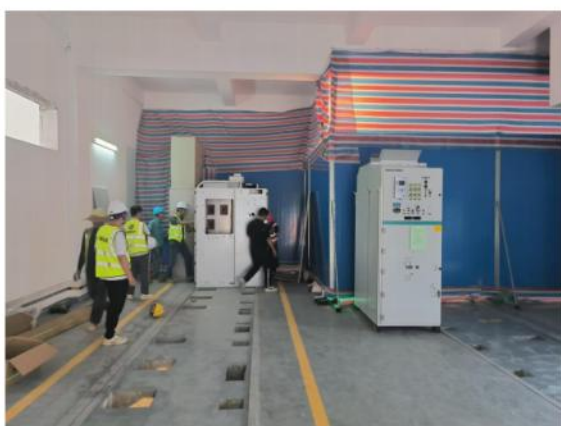
站内施工围蔽
