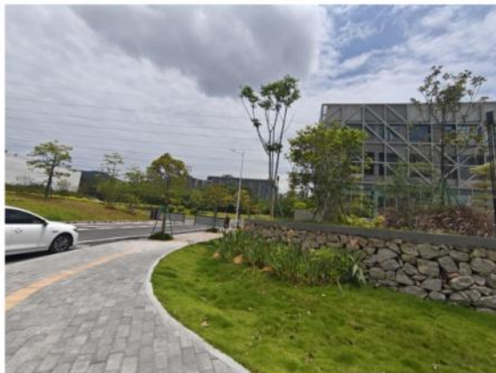
电缆通道两侧恢复、清理
