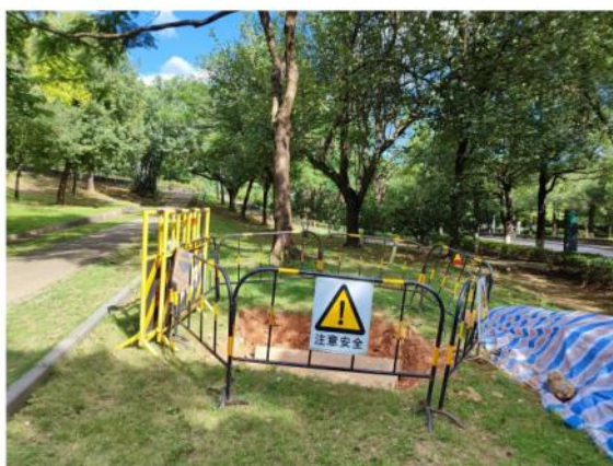
电缆建设彩布覆盖与安全警示
