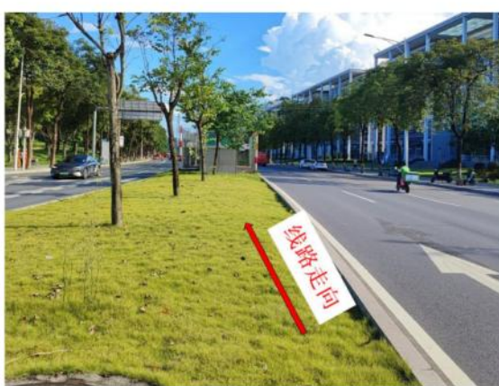
本工程电缆线路沿线（高唐路）
