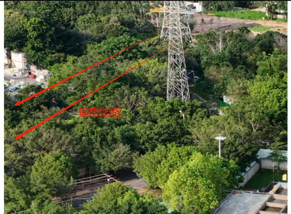
线路下方植被恢复良好
