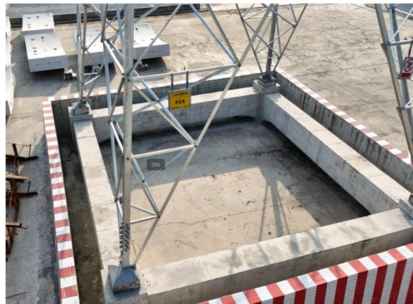
新建杆塔标示牌及防护围墙
