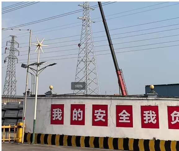
旧塔拆除施工过程中警示标语
