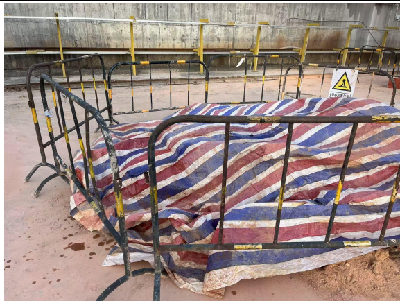
塔基施工过程中临时围挡与覆盖
