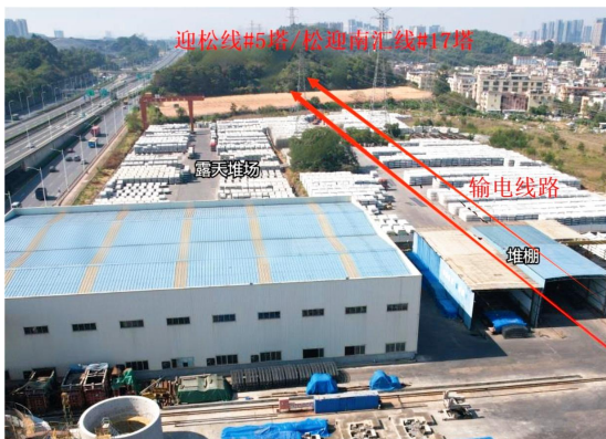
输电线路（中铁佛莞城轨项目部内部）
