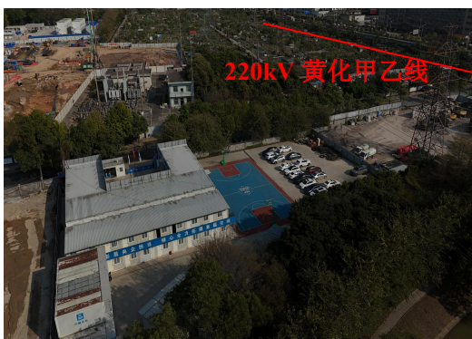
线路跨越文船路
