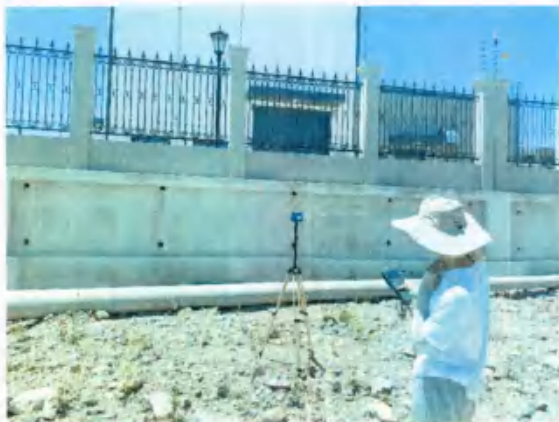
高溪 110kV 变电站东北侧 电磁环境检测照片
