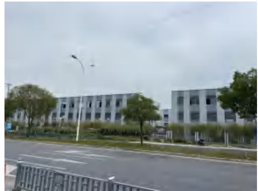
陆家 110kV 变电站站址 北侧环境现状
