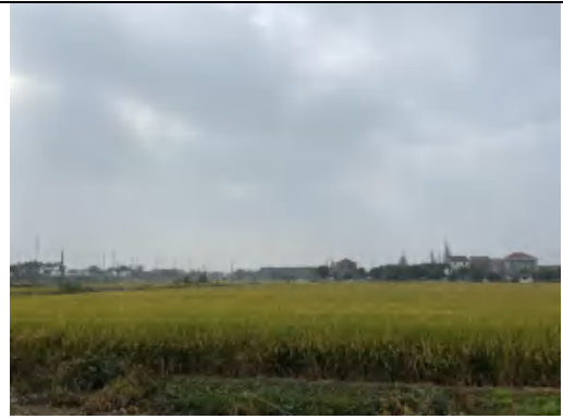
陆家 110kV 变电站站址 南侧环境现状
