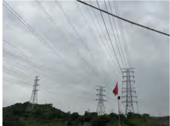
临时的 220kV 珠鱼乙线 沿线现状
