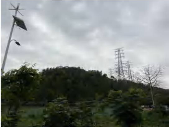
220kV 金乌甲乙线 沿线现状
