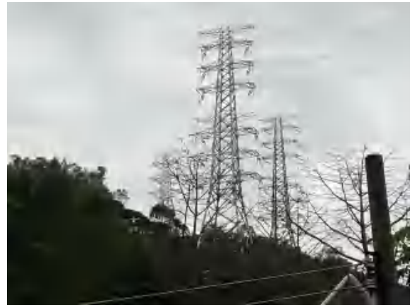
220kV 金乌甲乙线 2#塔基下方植被恢复
