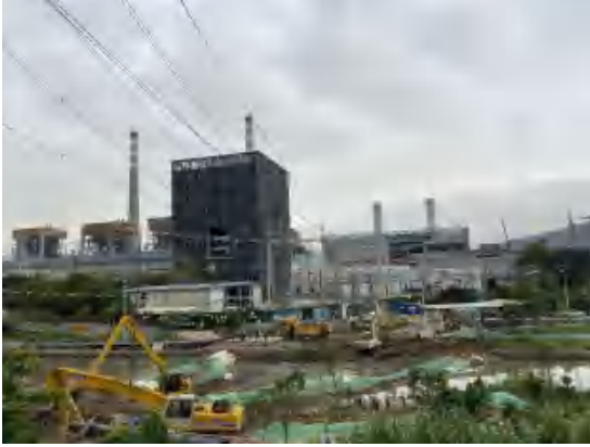
220kV 金乌甲乙线 沿线现状
