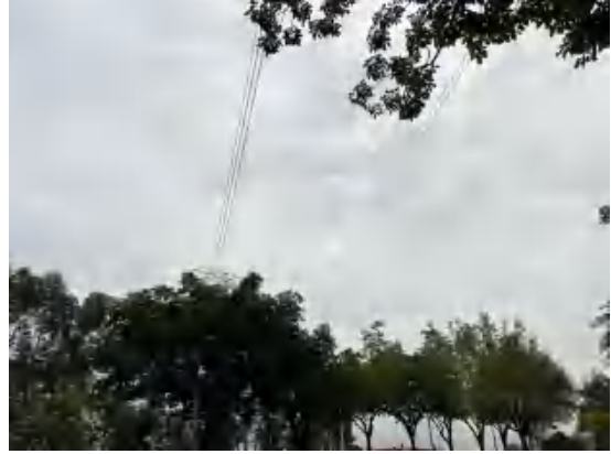
220kV 金乌甲乙线 沿线现状
