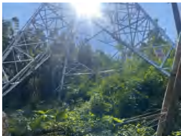
220kV 科雀甲乙线#C21 塔基恢复
