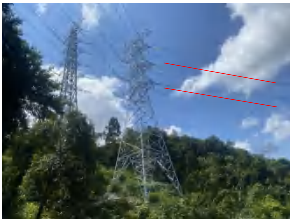
科雀甲乙线沿线现状 3
