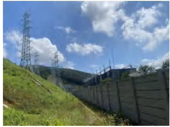
线路自 500kV 科北变电站出线
