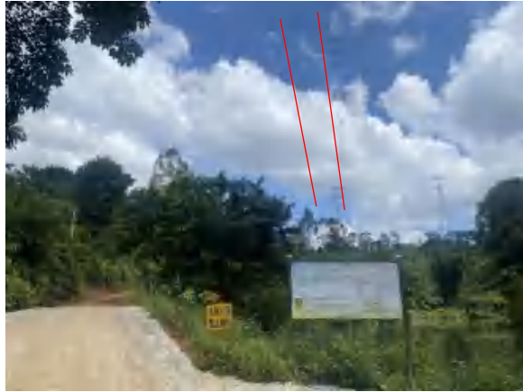
科雀甲乙线沿线现状 5
