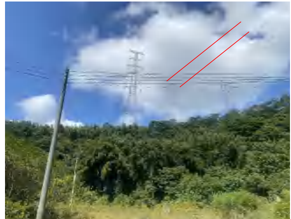
科雀甲乙线沿线现状 4
