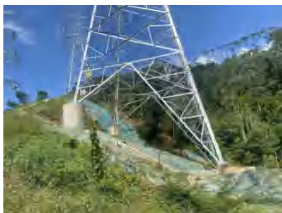
220kV 科雀甲乙线#C1 塔基恢复
