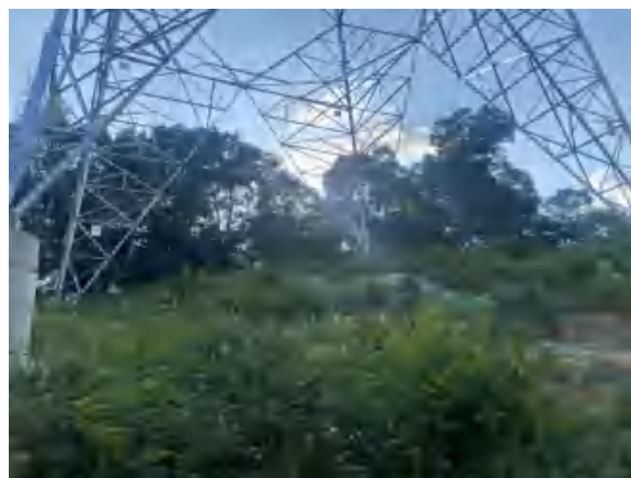
220kV 科雀甲乙线#C46 塔基恢复
