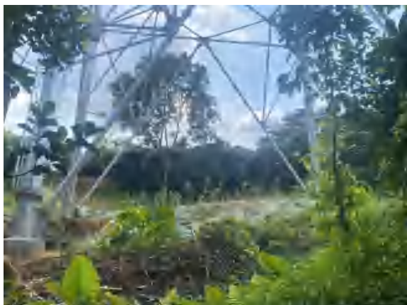
220kV科雀甲乙线#C32塔基恢复
