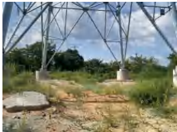
220kV科雀甲乙线#C35塔基恢复
