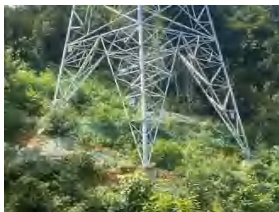
220kV 科雀甲乙线#C4 塔基恢复
