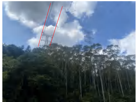
科雀甲乙线沿线现状 2
