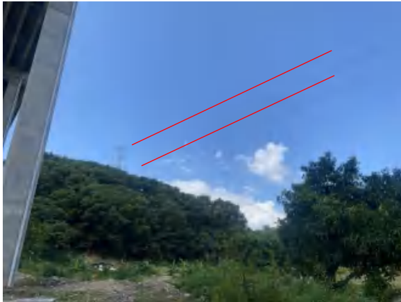
科雀甲乙线沿线现状 1
