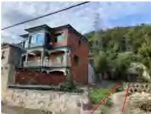
电缆线路沿线现状
