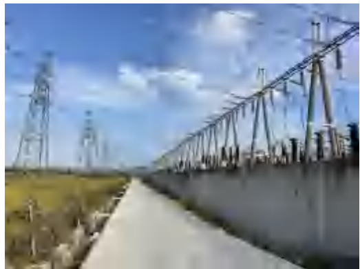
白塔变 110kV 间隔侧现状
