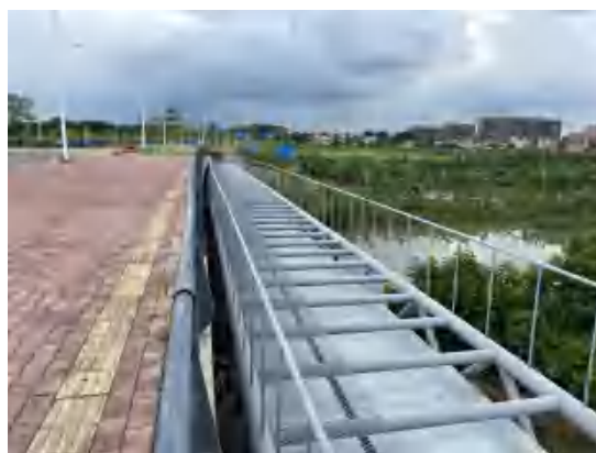
化龙~明经线路与化龙~复苏~明经电缆 线路同沟敷设段线路沿线
