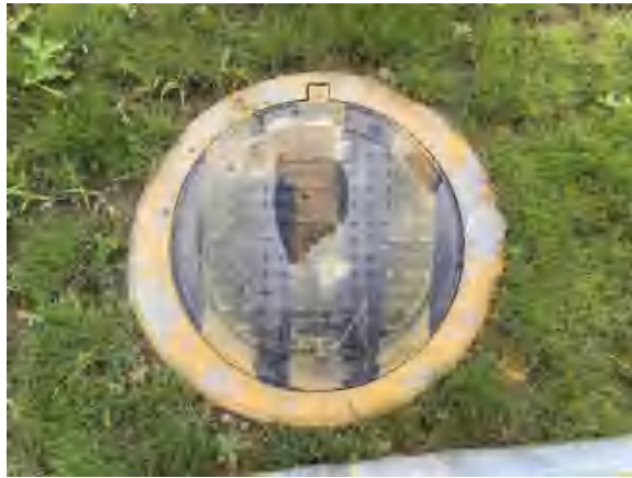
站内污水井盖
