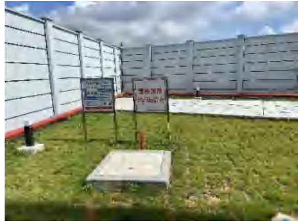
电缆沟路面硬化
