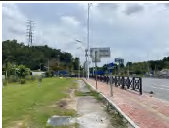
化龙~明经电缆线路沿线
