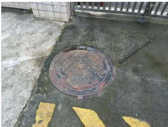
站内雨水井盖
