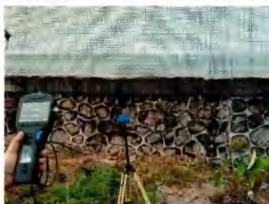
变电站东北侧围墙外电磁环境现状检测
