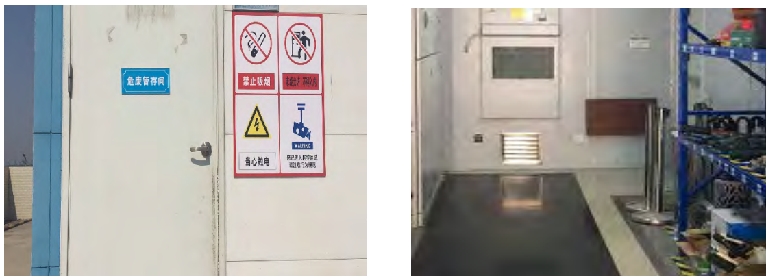
图 7-2 危废暂存间照片
