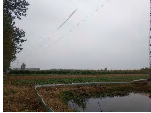
110kV 线路周边环境（二）
