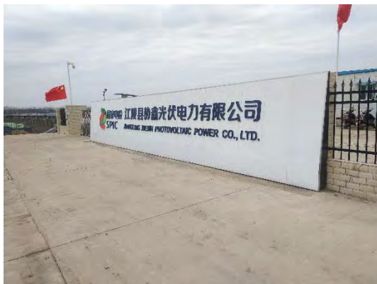
协鑫 110kV 升压站大门
