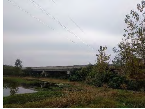
110kV 线路跨越枣石高速（#16~#17 塔）
