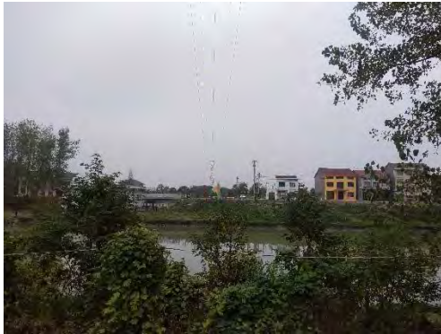
110kV 线路跨越四湖总干渠
