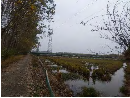
110kV 线路周边环境（一）
