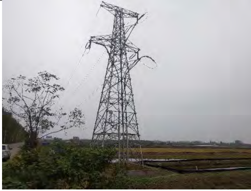
110kV 线路电缆转架空（#25 塔）
