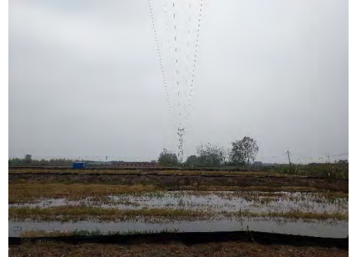
110kV 线路周边环境（四）
