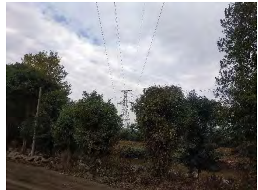
110kV 线路周边环境（八）
