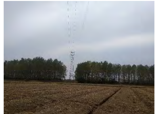
110kV 线路周边环境（六）
