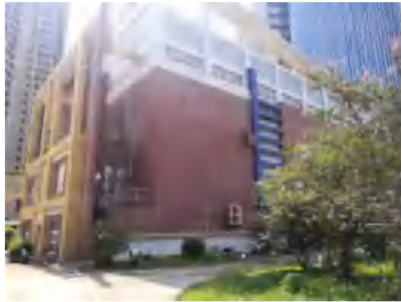
变电站主控楼
