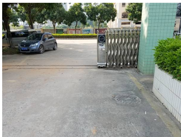
站内污水井盖
