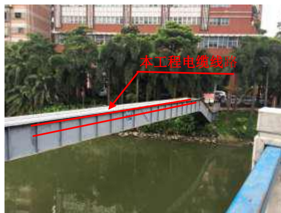
电缆线路跨越窖涌
