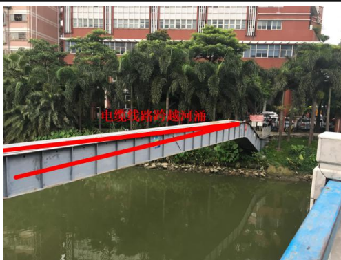
110kV线路跨越窑涌
