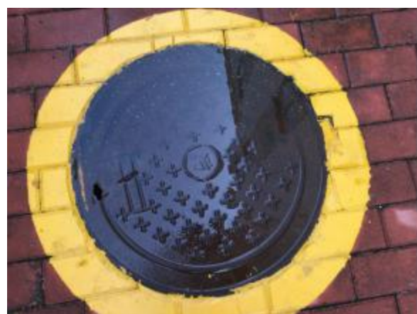
站内污水井盖
