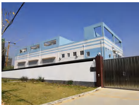
变电站主控楼
