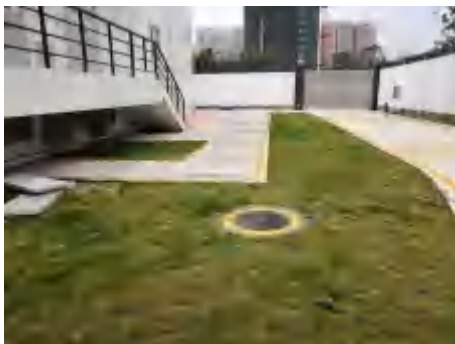
站内污水井盖
