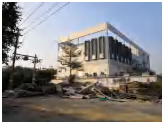
变电站主控楼
