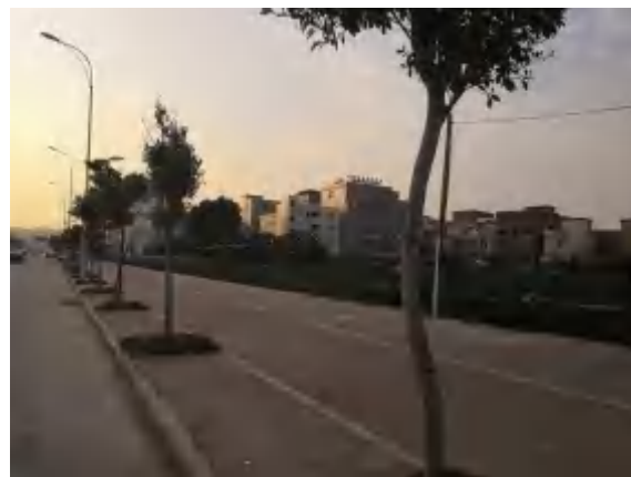
本工程电缆线路
