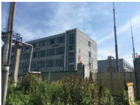
变电站北侧外环境
