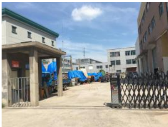
变电站西侧外环境
