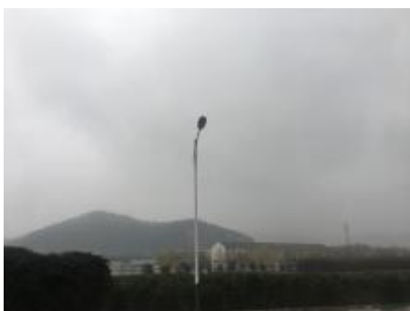
变电站北侧外环境
