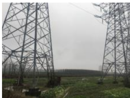
变电站东侧外环境
