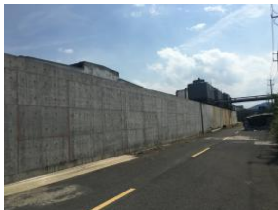
变电站南侧外环境
