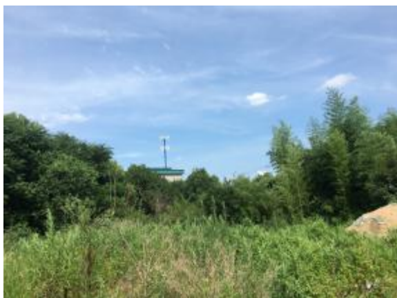
变电站西侧外环境
