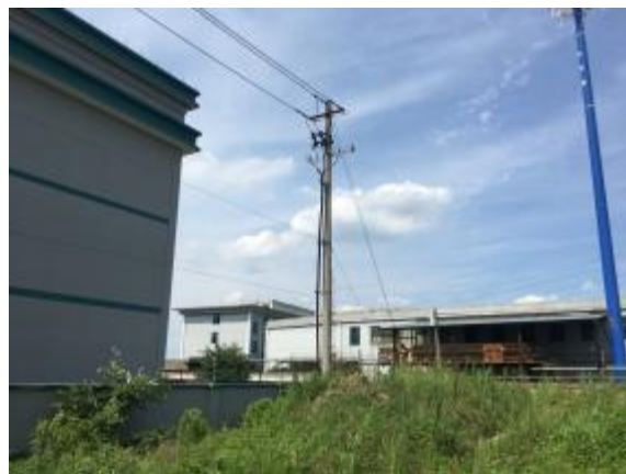
变电站东侧外环境
