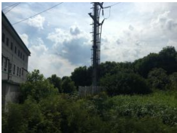
变电站北侧外环境
