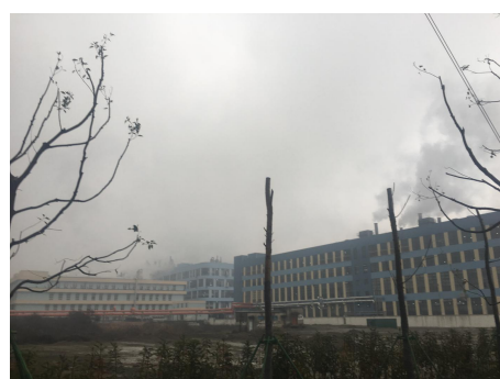
变电站东侧外环境
