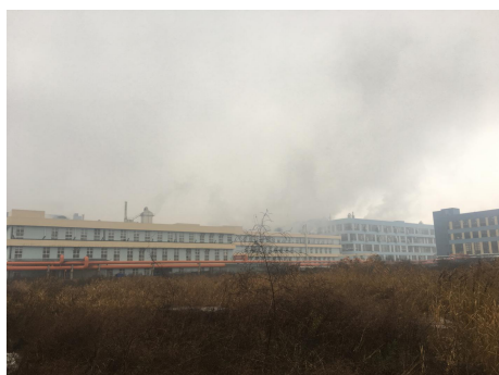
变电站北侧外环境
