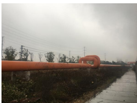
变电站西侧外环境
