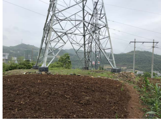
塔基植被恢复
