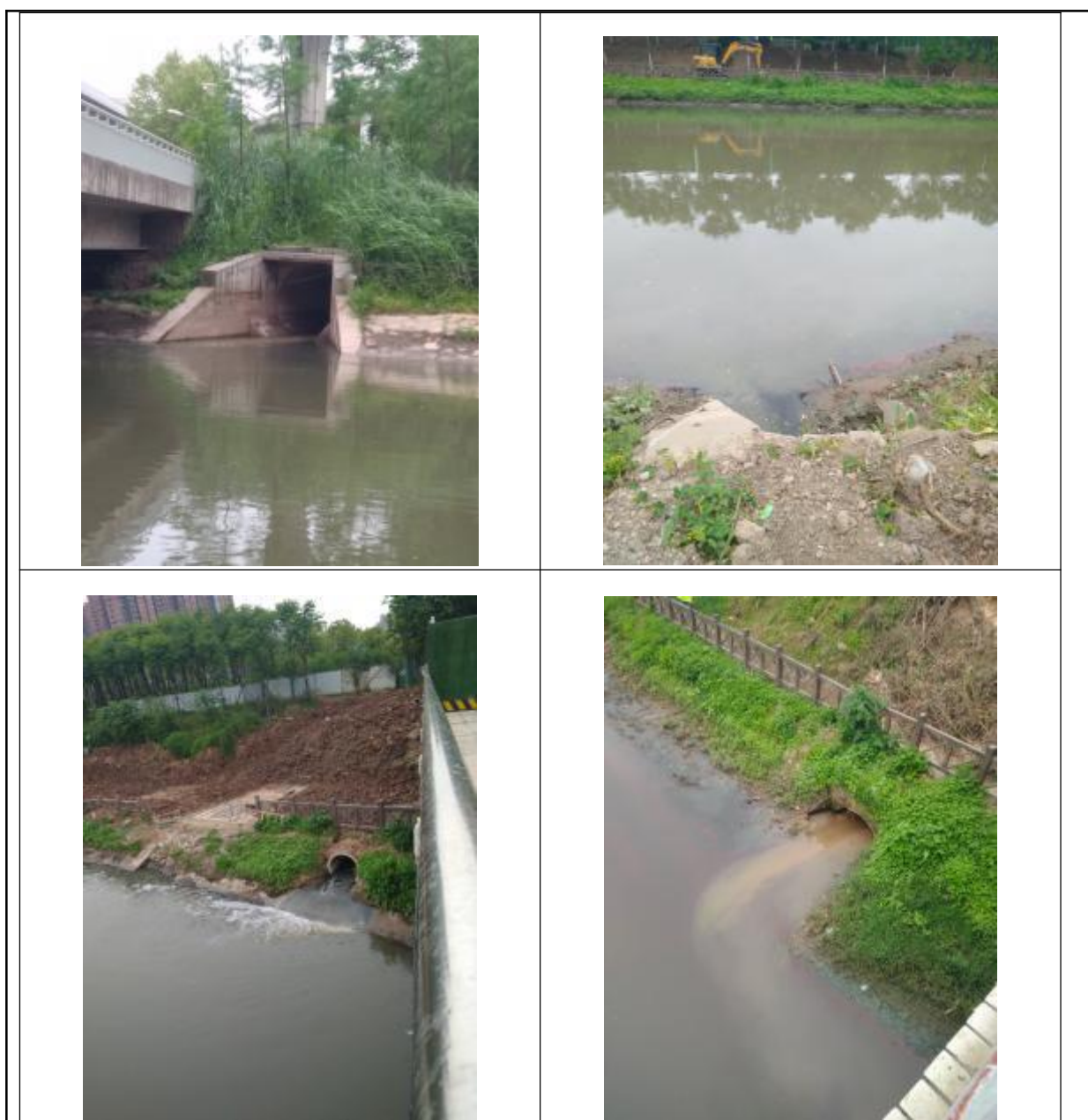
图 4-13 罗家港沿线现存排污口
