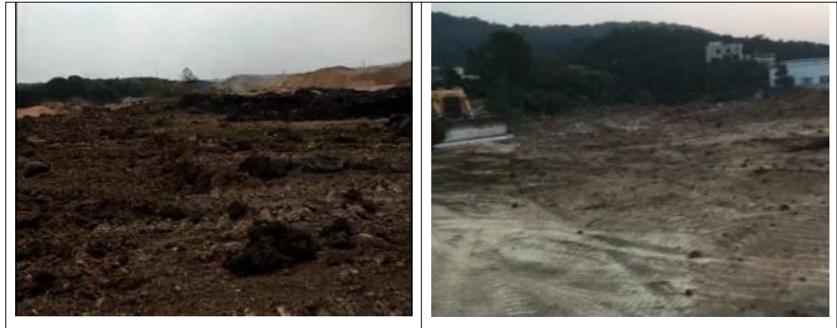
图4-18 北湖污水处理厂消纳场现状照片
