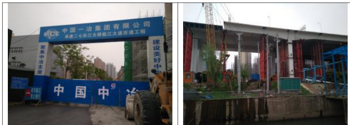
图4-14 原固化场现状照片
