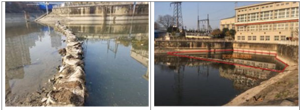
图4-6 围堰完工现场照片
