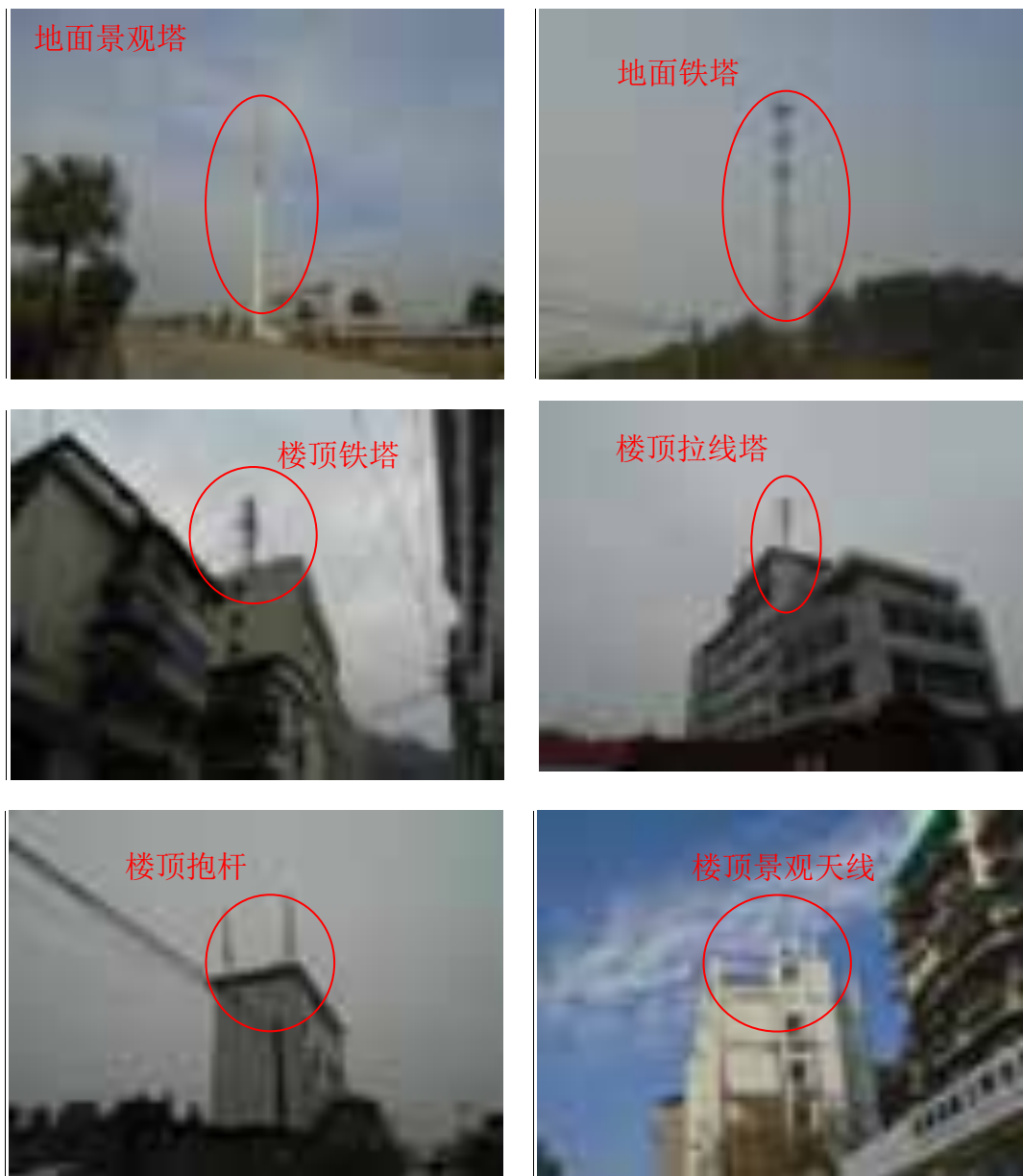
图 3-1 基站天线典型架设方式示意图
