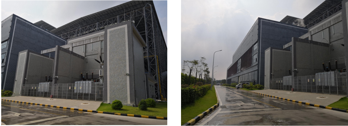
图 2-1 110kV 升压站站址现状
