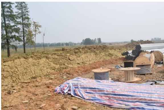
施工期临时生产区
