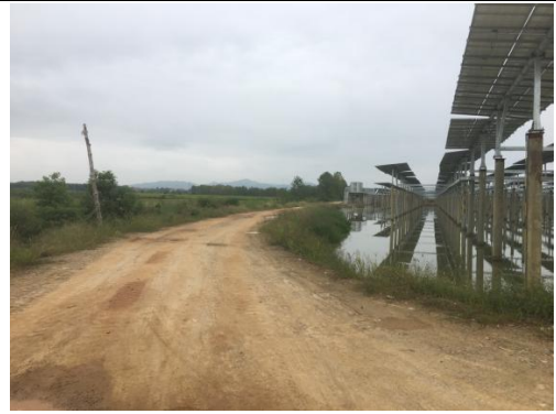
光伏场区道路平整及绿化
