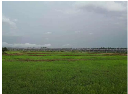
施工结束后临时道路迹地恢复
