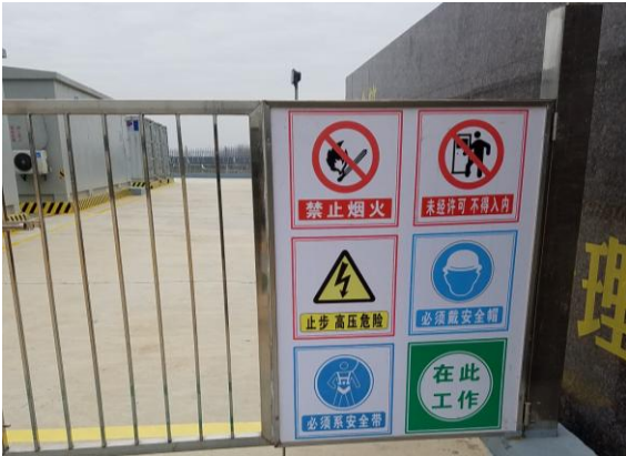
升压站出口处安全警示牌
