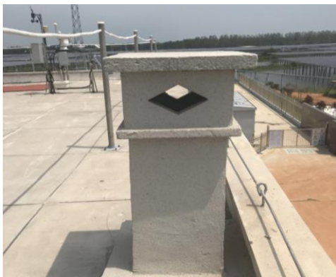
升压站内综合楼排放口（位于楼顶）
