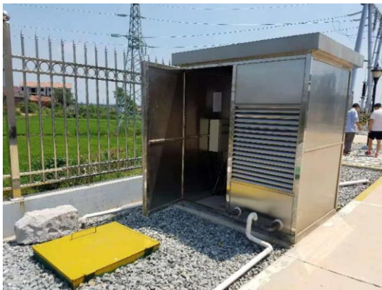
一体化污水处理设备控制室
