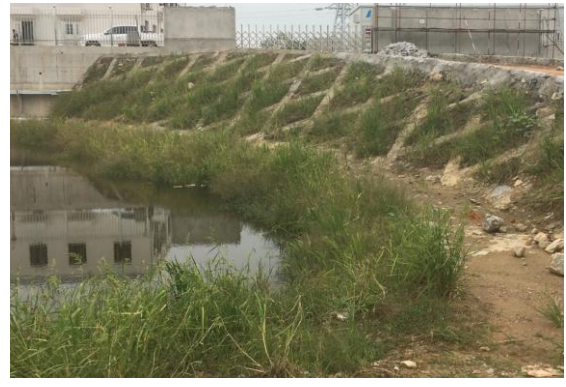
施工结束后升压站进站道路护坡及绿化
