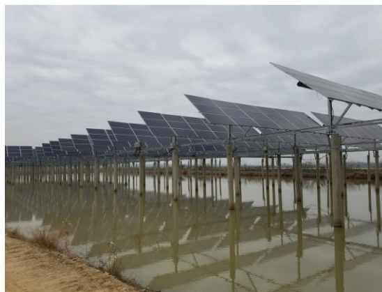
光伏场区矩阵
