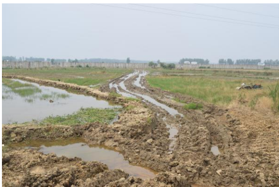
施工期光伏场区临时道路
