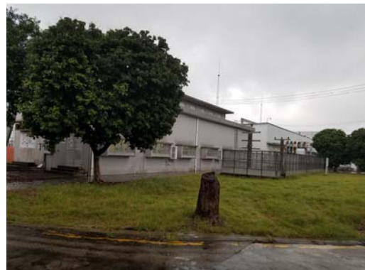
现有 10kV 配电室
