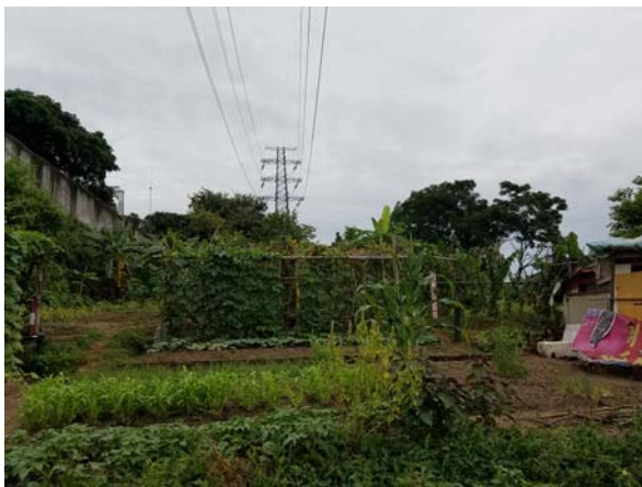
变电站东侧外环境
