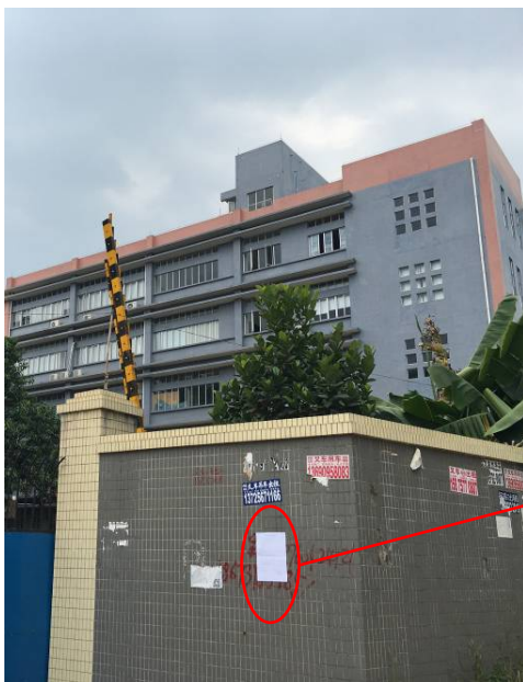
广州市乐家生鲜便利连锁有限公司厂区出入口公示（远景）
