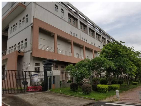
220kV 奥林变电站进线侧
