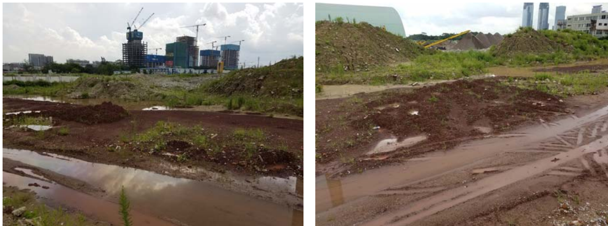
图 2-1 拟建 220kV 员热变电站站址现状
